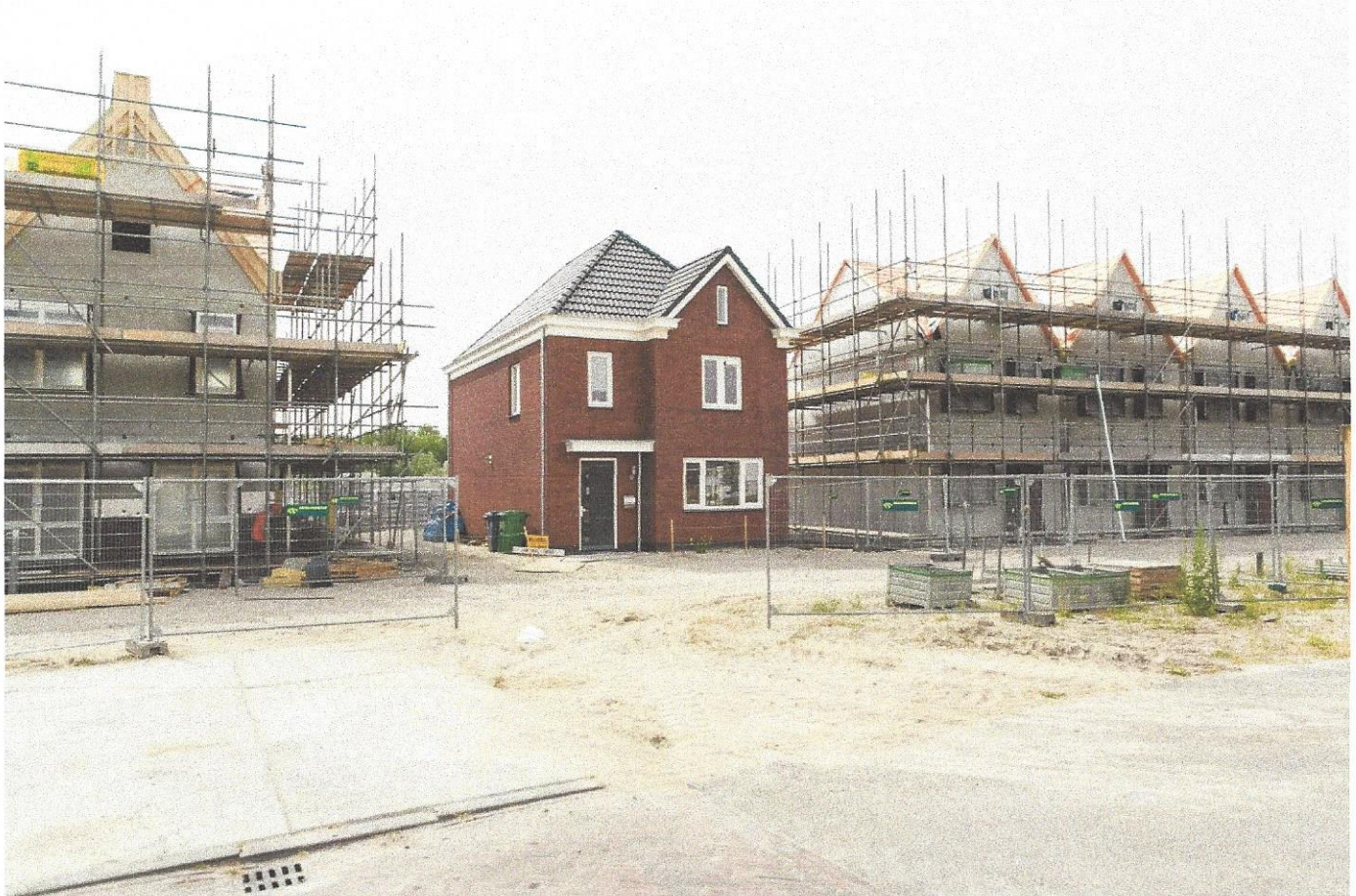
Bouwwerkzaamheden in een van de nieuwste wijken van Almere: Nobelhorst.
